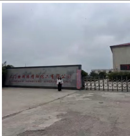
工程师看现场照片
