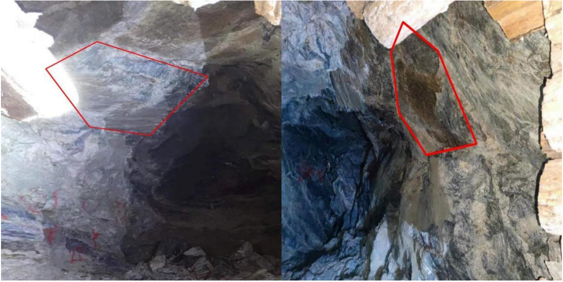
图 2-1 巷道冒落点照片
