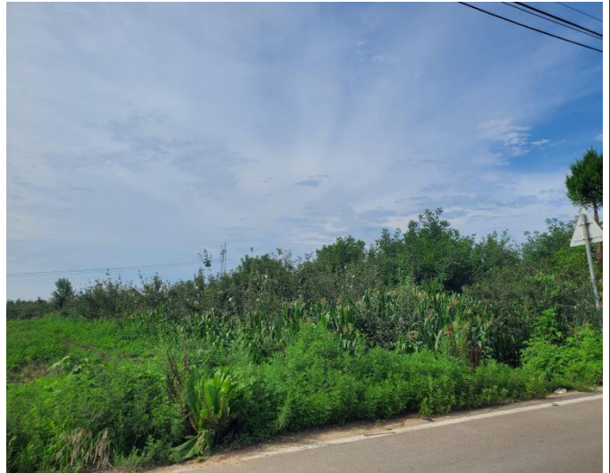
吊坡水库渠道清淤工程终点
